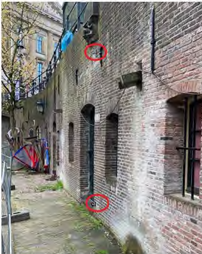
Figuur 4: Voorbeeldfoto positie prisma's (rood omcirkeld)
